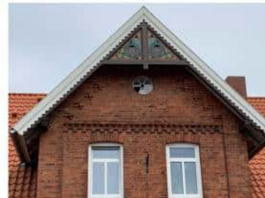
Detail Aufarbeitung Schmuckgiebel (Kirchgellersen)
