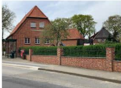
BV Erneuerung straßenseitige Einfriedung Mauer mit Pfeiler und Schmiedezium sowie Heckerganzung (Kirchgellersen)
