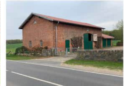
BV Erneuerung Dacheindeckung, Tore und Fenster Scheune (Westergellersen)
