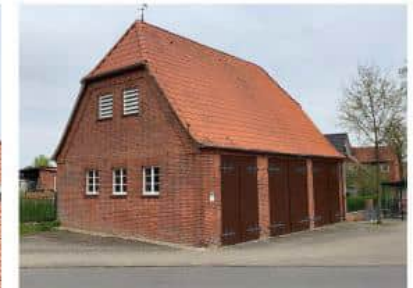
BV Dach- und Fenstersanierung altes Feuerwehrgebäude (Kirchgellersen) BV Erneuerung Tore (öffentliches Förderprojekt)
