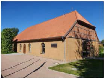
BV Erneuerung der Dacheindeckung und Lehmfassaden der „Lehmschüür“ (Westergellersen)
