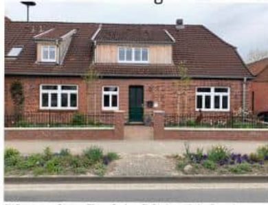
BV Erneuerung Fenster, Türen, Giebeln, Einfriedung (Kirchgellersen) BV Revitalisierung von Wohnraum (Innenausbau)
