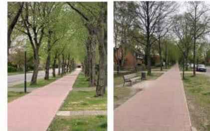
BV Aufwertung innerörtlicher Fuß- und Radwegeverbindungen, hier: Schulwegesicherung am Einemholer Weg (Kirchgellersen)
