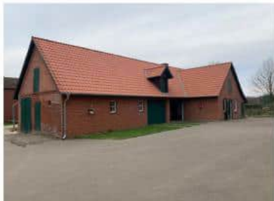
BV Erneuerung Dacheindeckung landwirtschaftliches Nebengebäude (Dachmissen)
