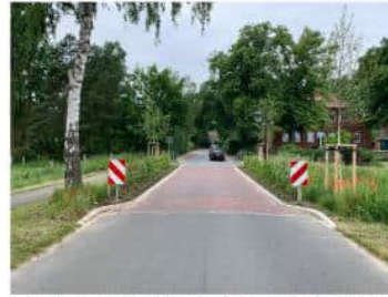
BV Verkehrsberuhigende Maßnahmen am Ortseingang Dachmissen aus Ri. Reperstedt, Fahrbahnverengung mit Anpflanzungen (Baumtor u. Hecke)
