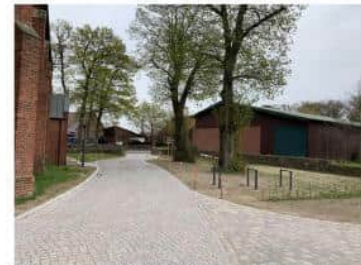
BV Erneuerung der Zufahrten und Stellplatzflächen für Fahrzeuge und Fahrräder
