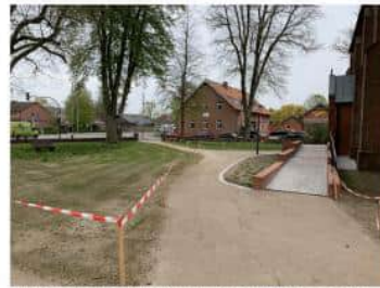
BV Einbau einer barrierefreien Rampe und Erneuerung der wassergebundenen Zugewegungen St. Laurentius Kirche (Kirchgellersen)
