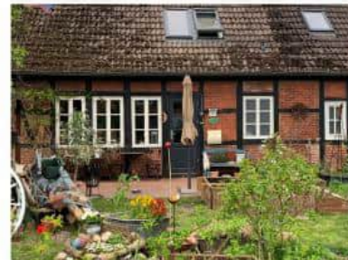
BV Erneuerung Fenster und Türen Wohnhaus (Kirchgellersen)
