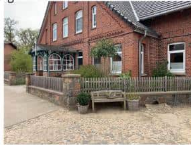
BV Erneuerung Veranda / Eingangsbereich (Kirchgellersen) BV Sanierung Einfriedung (Mauerpfeiler mit Lattenzaun)
